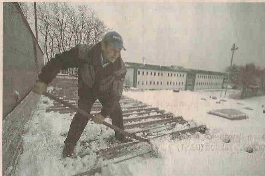
Räumeinsatz gestern auf dem Dach der Sporthalle Berg Fidel.
